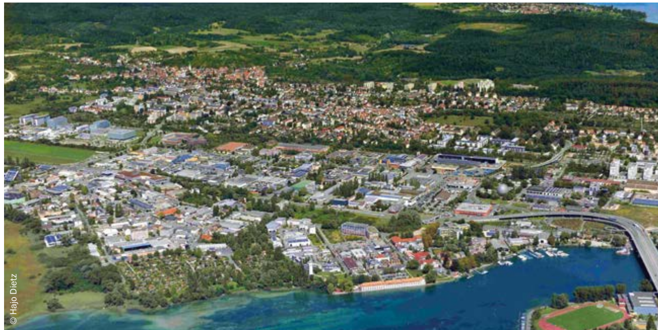
Mit der neu erarbeiteten Förderrichtlinie „Leuchtturmförderung Gewerbe“ können seit dem 1. Juli 2023 auch Nichtwohngebäude eine Förderung für energetische Sanierungsmaßnahmen erhalten.
